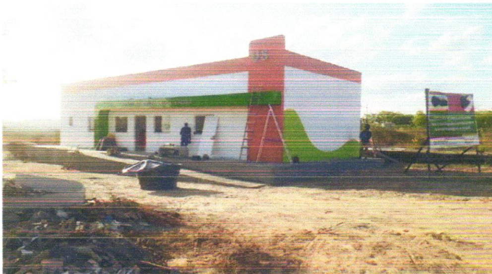
Foto 18 - APLICAÇÃO MANUAL DE PINTURA COM TINTA LÁTEX ACRÍLICA EM PAREDES, DUAS DEMÃOS. AF_06/2014
