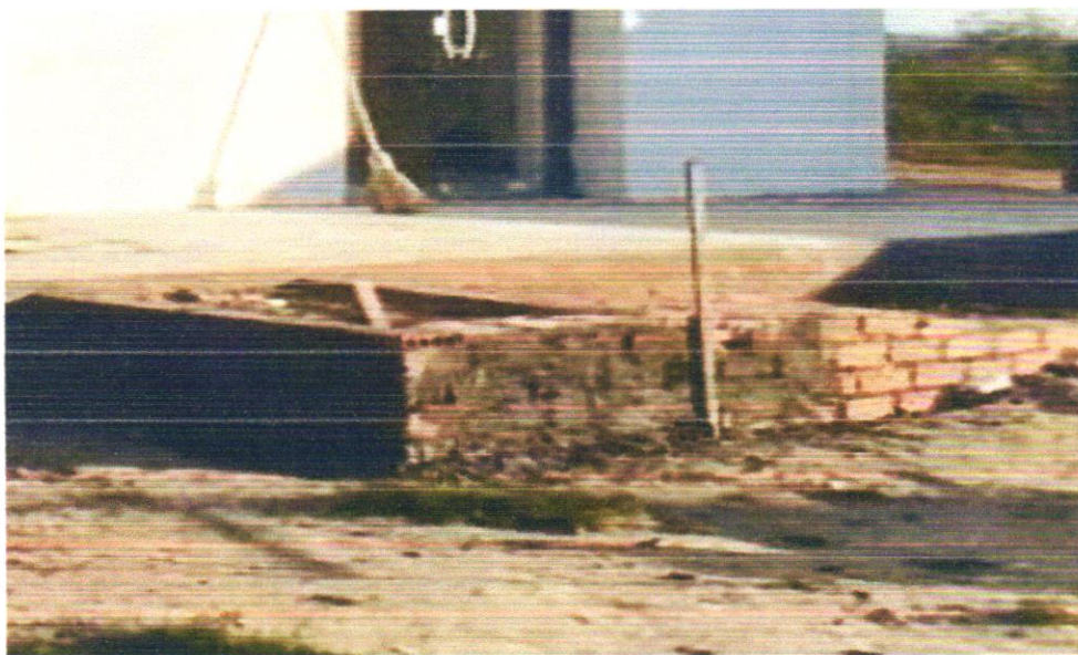
FOTO 07 - Alvenaria tijolo cerâmico maciço (5x9x19), esp = 0,05m (facão), com argamassa traço t5 - 1:2:8 (cimento / cal / areia) c/ junta de 2,0cm - R1
