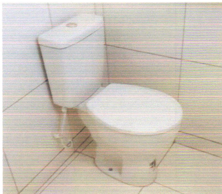
FOTO 12 - VASO SANITARIO SIFONADO CONVENCIONAL COM LOUÇA BRANCA - FORNECIMENTO E INSTALAÇÃO. AF_01/2020
